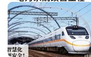
臺鐵(台北-高雄)電務智慧化
